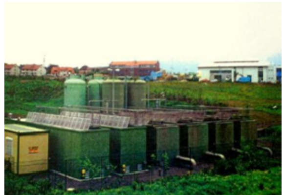
Kommunale Abwasserreinigung für 5000 EW
