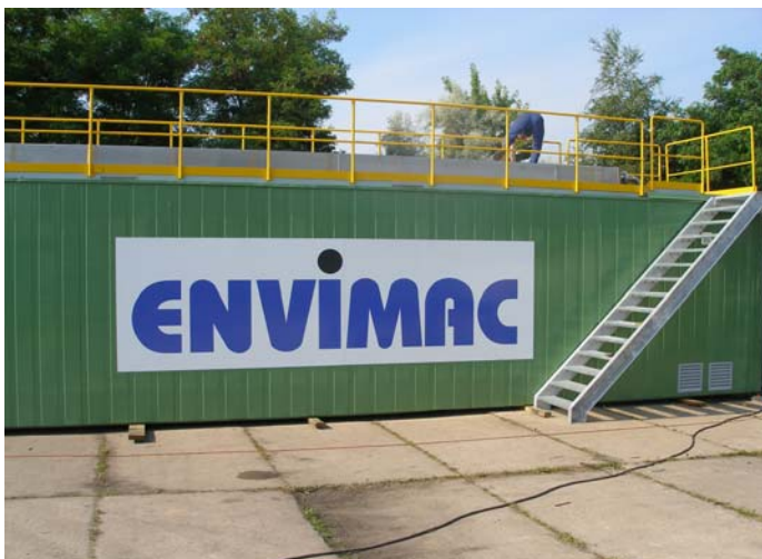
Kommunale Abwasserreinigung für 700 EW
